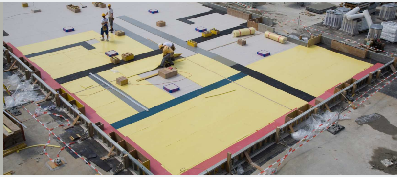
Drachen Center, Basilej, Švýcarsko: celoplošné uložení budovy
